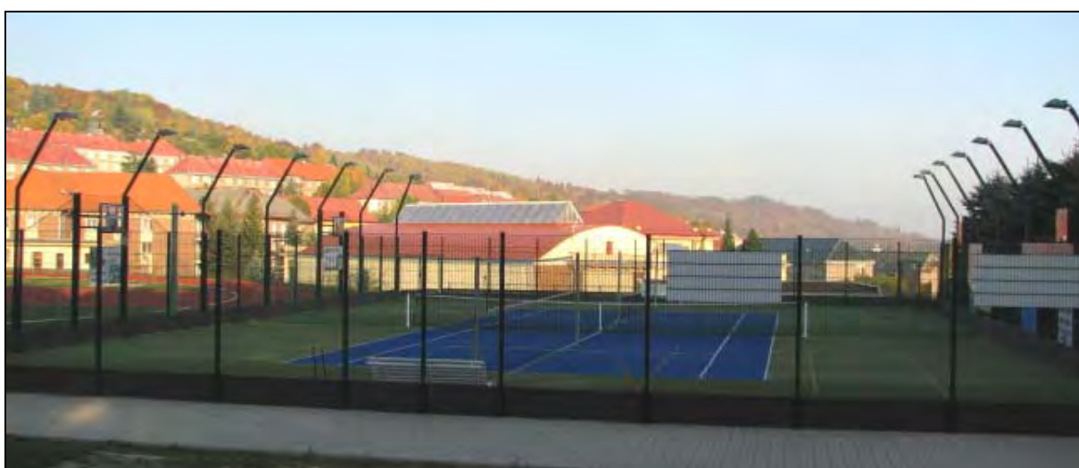
Osvětlené víceúčelové hřiště s umělým povrchem (nohejbal, volejbal, tenis)
