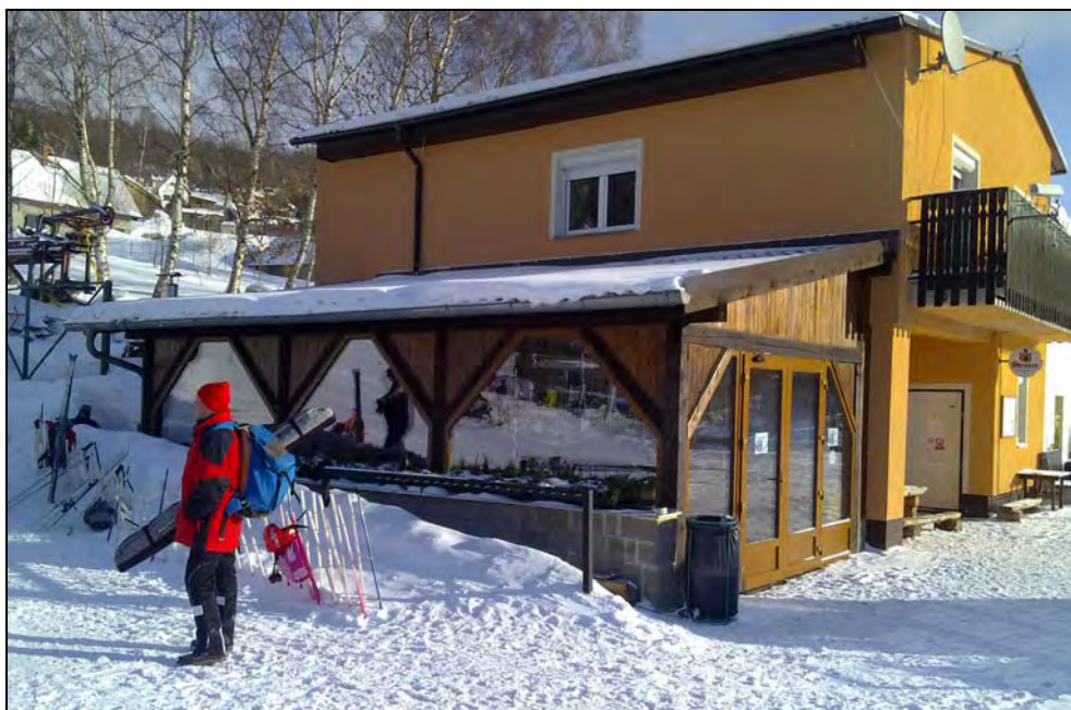
Nová prosklená přístavba (SKI areál Meziboří, 29.12. 2010)
